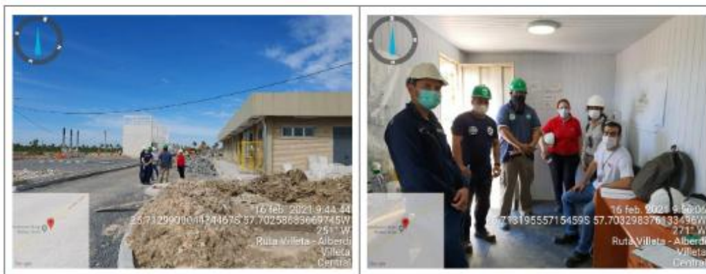
Fotos Nros. 3 y 4. Zona de Obra – Auditoría de Campo Conclusiva
