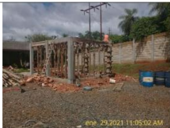
Ilustración 5: Frente de trabajo, personal con EPI.
