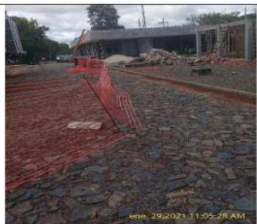
Ilustración 2: Delimitación con malla.
